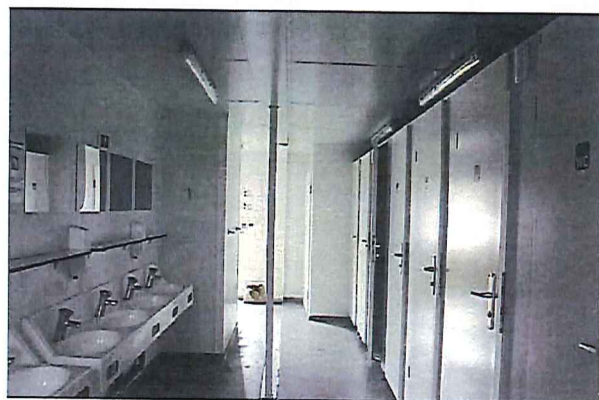
Vues intérieures état existant
