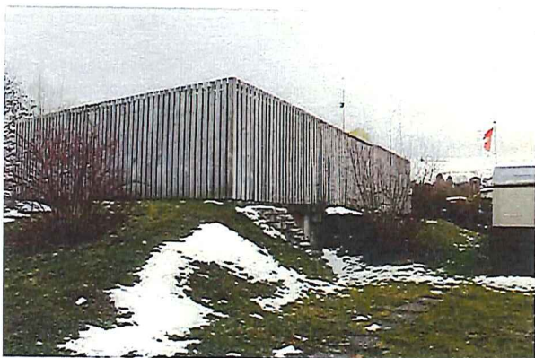
Vues extérieures état existant
